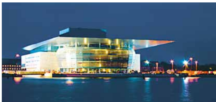
Здание Оперы (Копенгаген)
